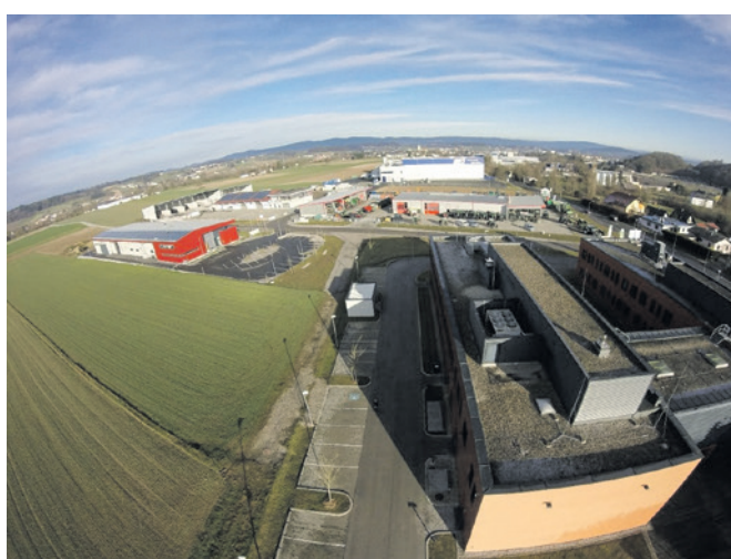
LUFTAUFNAHME des TFZ-Wieselburg und des neuen Feuerwehrhauses mit PV-Anlage.
