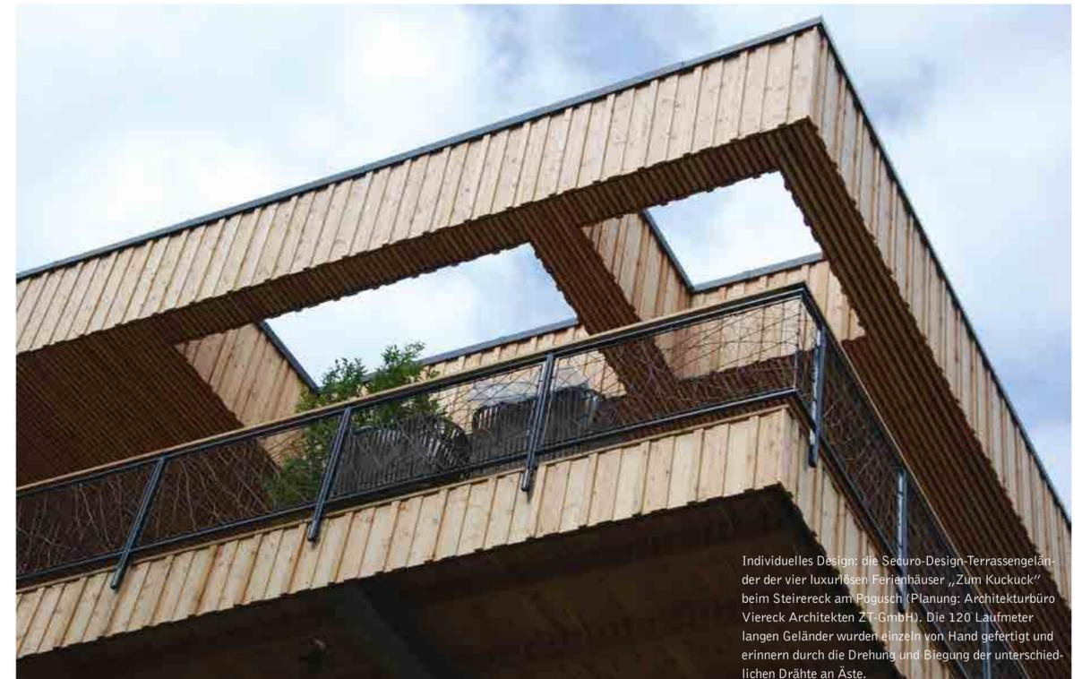
Individuelles Design: die Securo-Design-Terrassengeländer der vier luxuriösen Ferienhäuser „Zum Kuckuck“ beim Steirerleck am Pogusch (Planung: Architekturbüro Viereck Architekten ZT-GmbH). Die 120 Laufmeter langen Geländer wurden einzeln von Hand gefertigt und erinnern durch die Drehung und Biegung der unterschiedlichen Drähte an Äste.
