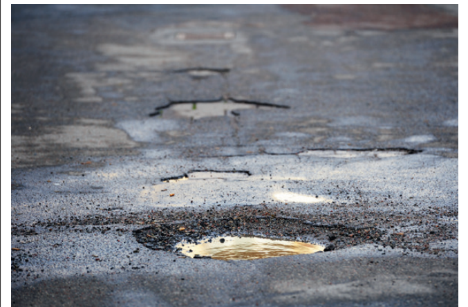
Das mehr als 5.000 km lange Netz der steirischen Landesstraßen ist teilweise in einem desolaten Zustand.
