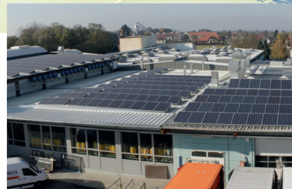
Photovoltaikanlage Katzbeck, eine der größten PV-Anlagen im Burgenland auf dem Dach eines Industrieunternehmens: ERHART-EMS lieferten die PV-Standortentwicklung, Beschaffung und Umsetzungsbegleitung.
